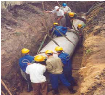
Lắp đặt công kênh, độ bền thấp
